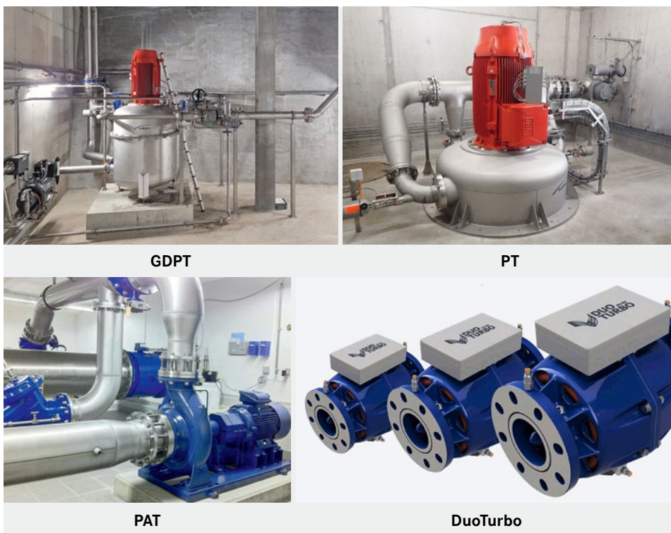
Fig. 1 Turbinenbauformen.
